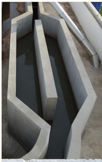
Figura 4 – Representação esquemática de uma caixa de areia.
