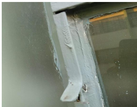
Figura 02 e 03 (respectivamente). Enrugamentos em esquadrias do Campus
