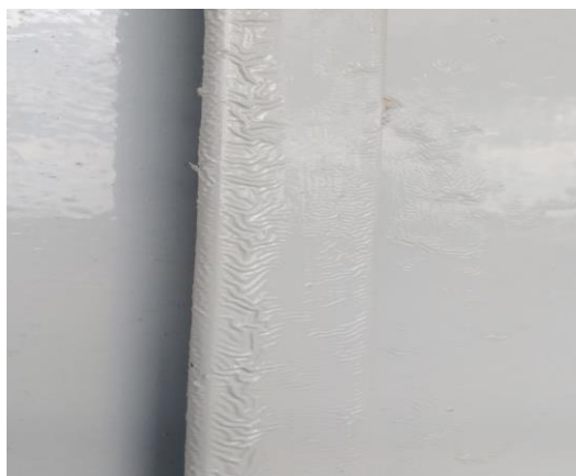
Figura 02 e 03 (respectivamente). Enrugamentos em esquadrias do Campus
