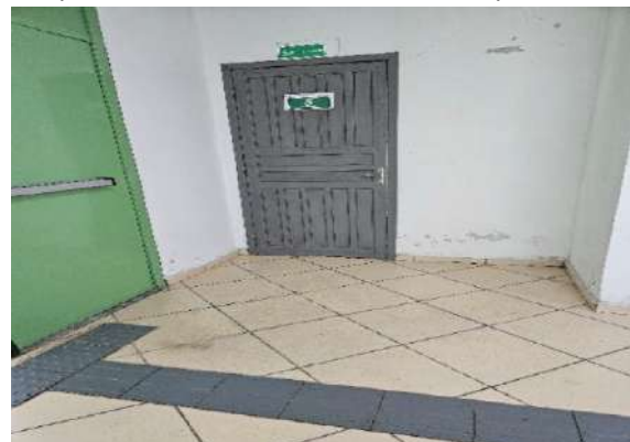
Figura 20 – Prédio A (Porta de saída e Banheiro PNE)
