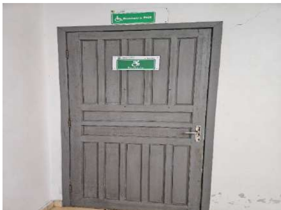
Figura 19 – Prédio A (Banheiro PNE)
