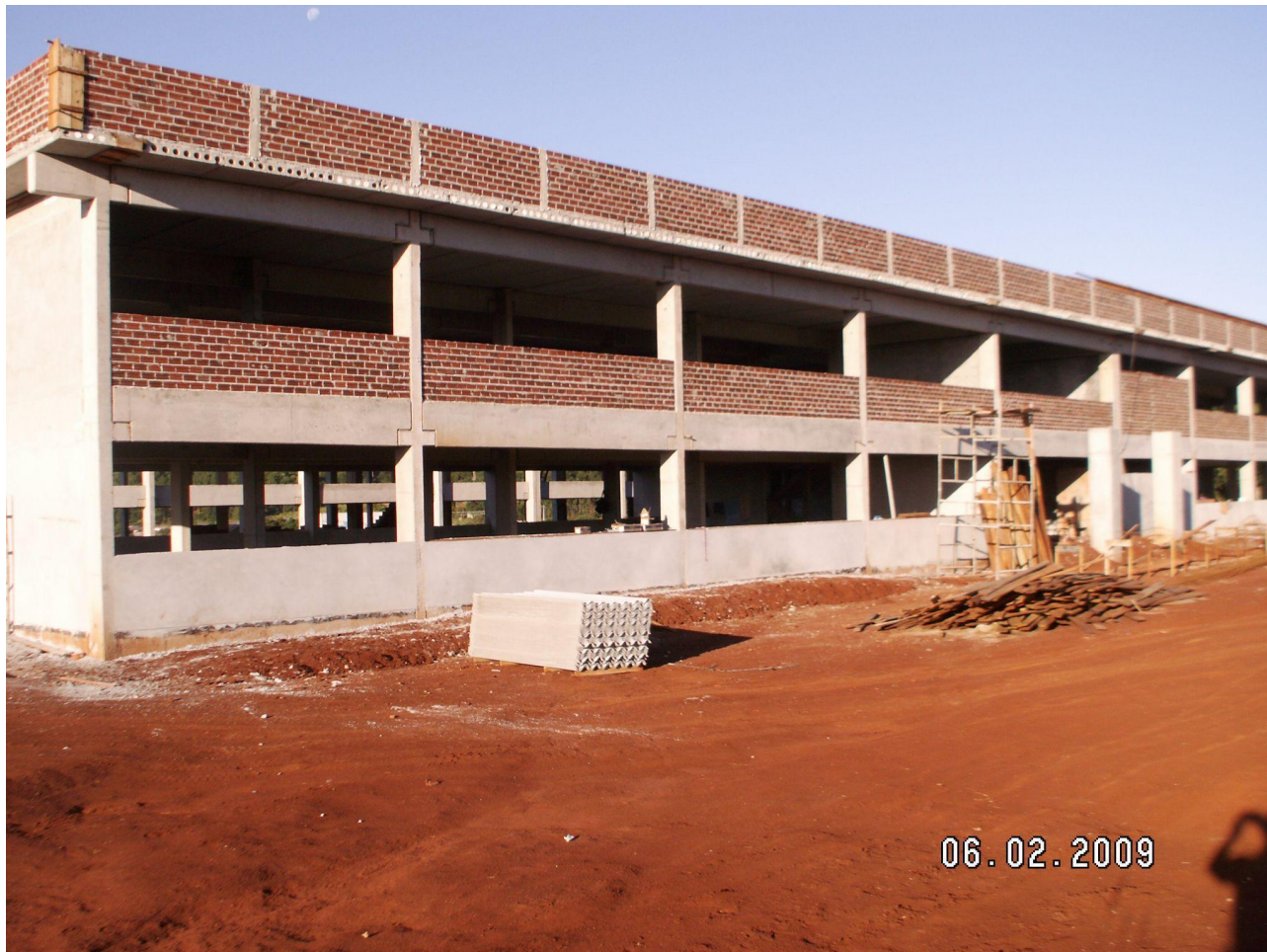
Construção dos prédios A e B
